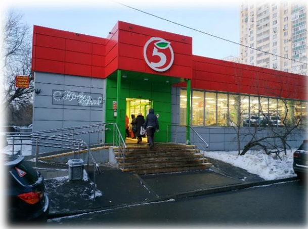
Фотография 3.3. Прилегающая территория, фасад здания
