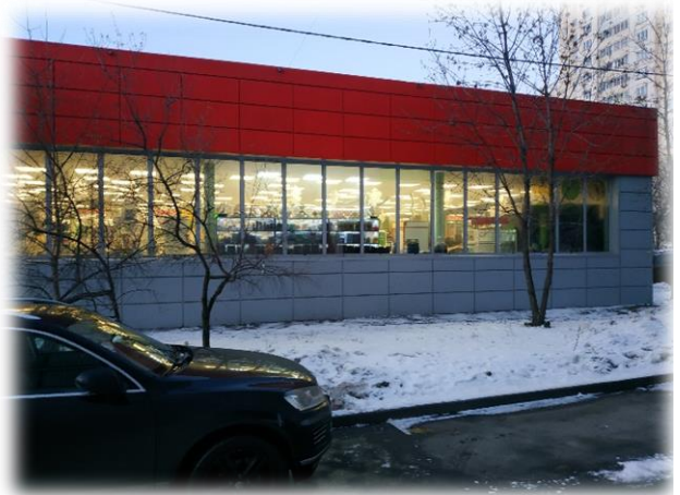
Фотография 3.4. Прилегающая территория, фасад здания
