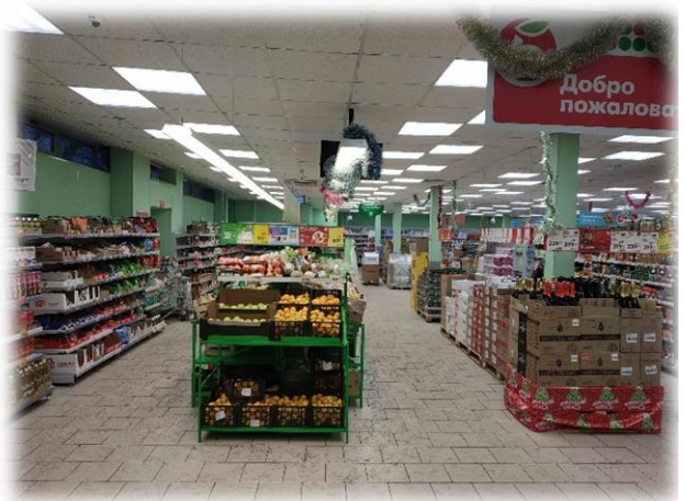
Фотография 3.6. Состояние внутренних помещений
