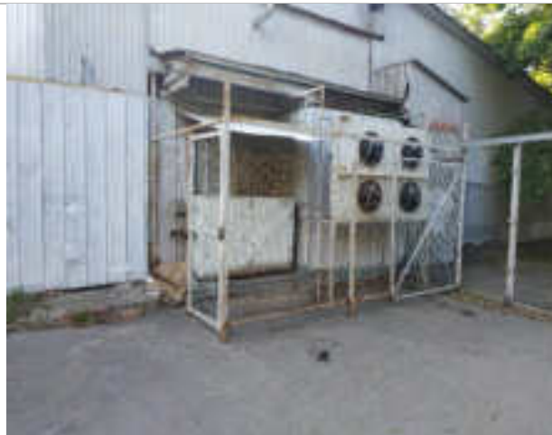
Фото 3. Внешний вид здания
