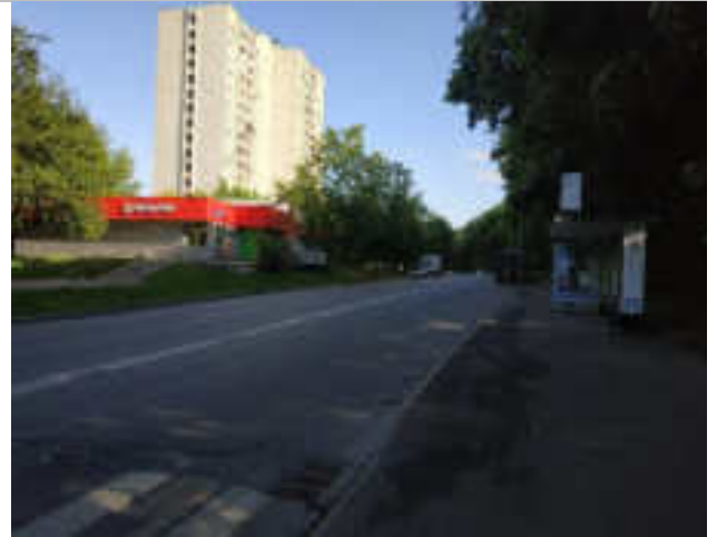
Фотография 3.2. Подъездные пути, фасад здания
