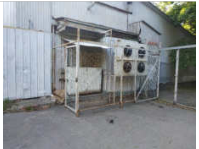
Фотография 3.4. Прилегающая территория, фасад здания
