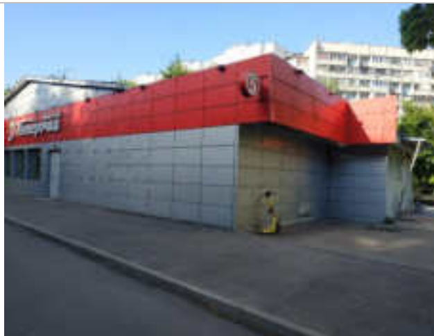
Фотография 3.3. Прилегающая территория, фасад здания
