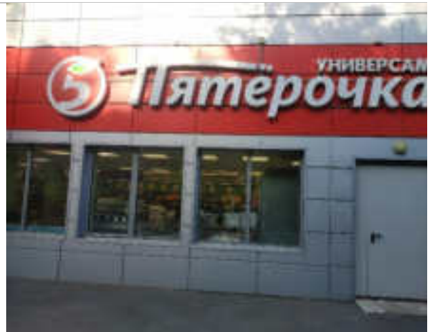
Фото 4. Внешний вид здания
