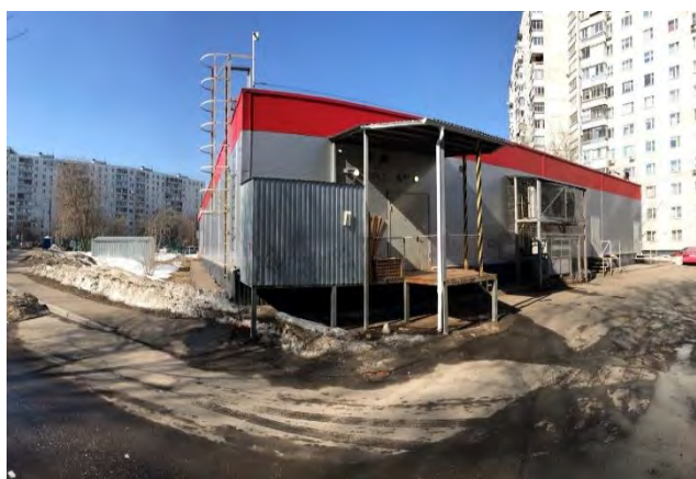
Фото 7. Внешний вид здания
