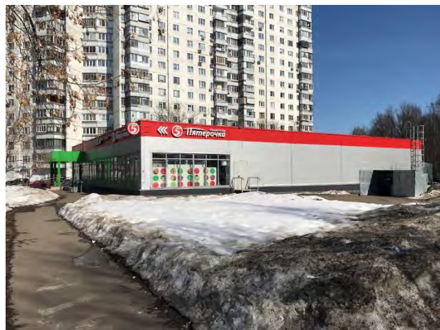
Фото 2. Внешний вид здания
