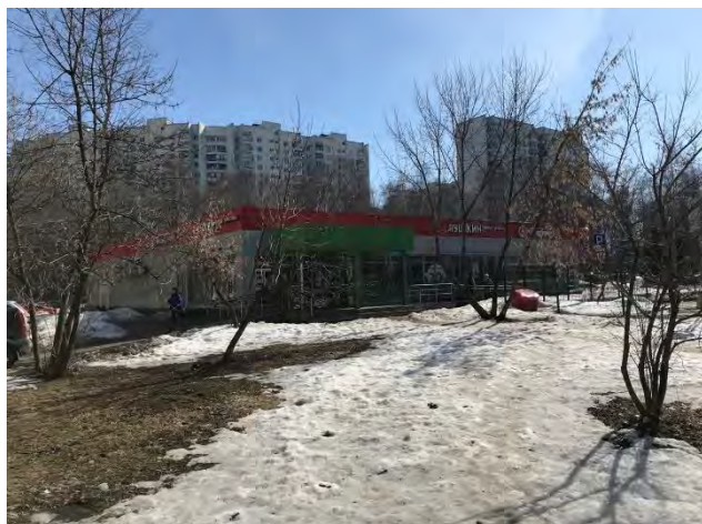
Фото 1. Внешний вид здания
