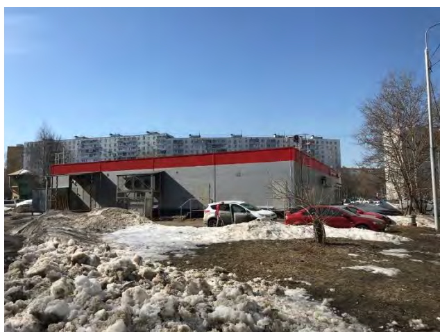
Фото 5. Внешний вид здания
