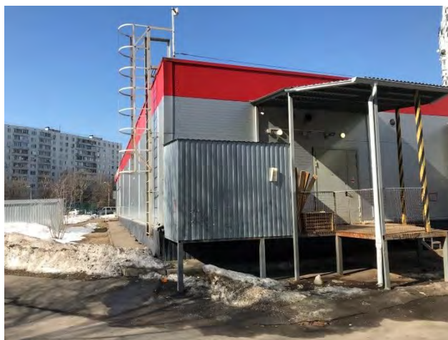
Фото 4. Внешний вид здания
