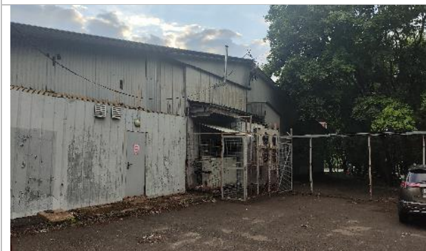
Фото 21. Фасад здания и прилегающая территория.
