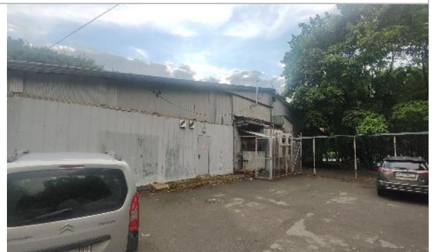
Фото 20. Фасад здания и прилегающая территория.
