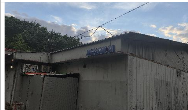
Фото 23. Фасад здания и прилегающая территория.
