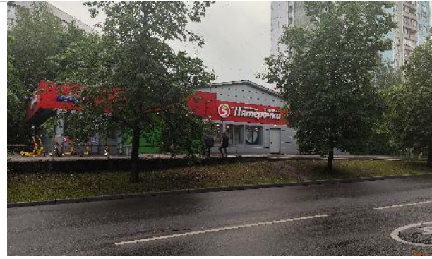
Фото 33. Фасад здания и прилегающая территория.
