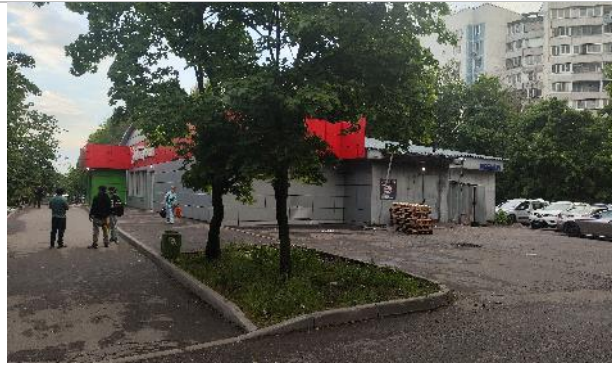
Фотография 3.4. Прилегающая территория, фасад здания
