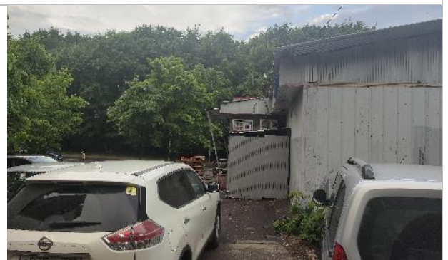
Фото 22. Фасад здания и прилегающая территория.
