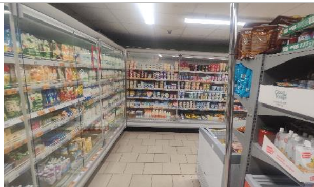
Фотография 3.10. Состояние внутренних помещений
