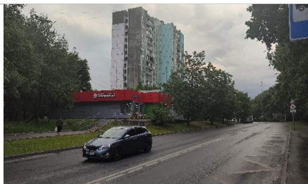
Фото 31. Фасад здания и прилегающая территория.
