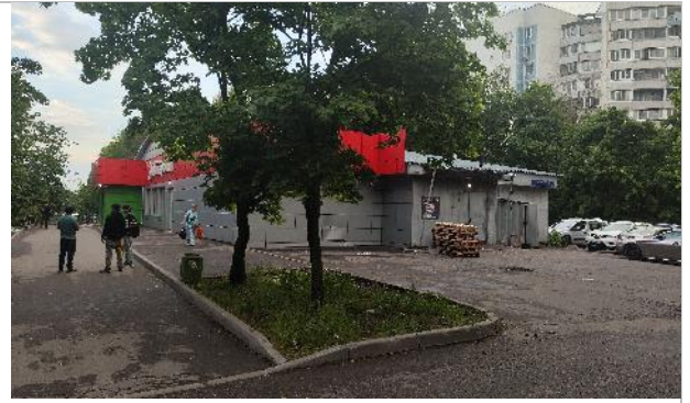
Фото 34. Фасад здания и прилегающая территория.
