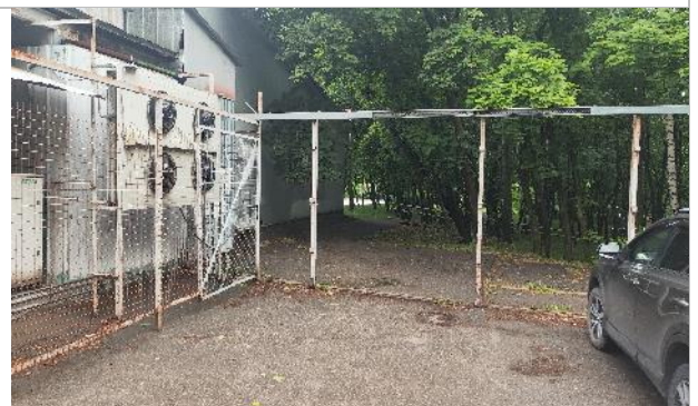
Фото 24. Фасад здания и прилегающая территория.
