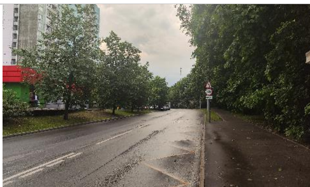
Фото 32. Фасад здания и прилегающая территория.
