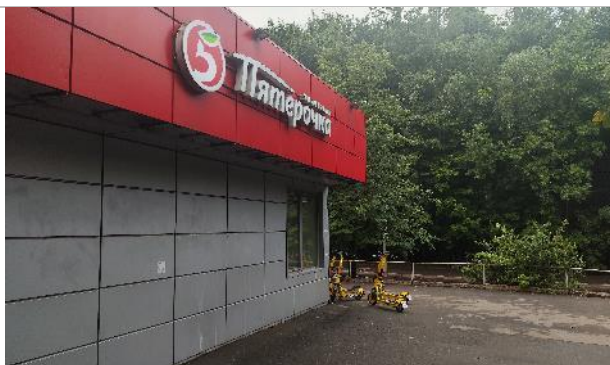
Фото 26. Фасад здания и прилегающая территория.
