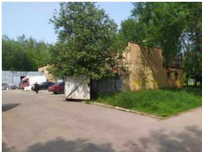
Общий вид здания котельной
