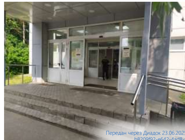
Входная группа здания площадью 2 110 кв. м
