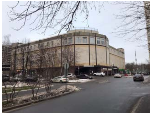
Фото 4. Внешний вид здания
