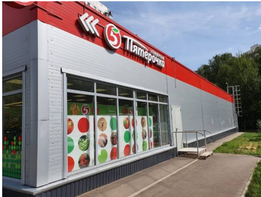
Фото 2. Внешний вид здания
