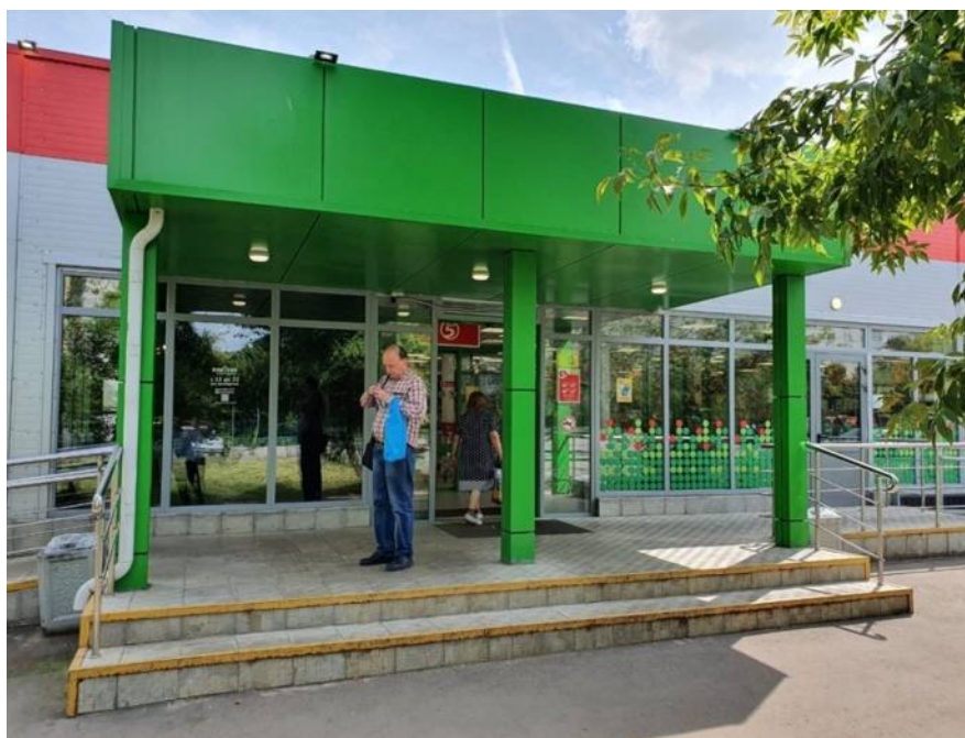
Фото 5. Внешний вид здания
