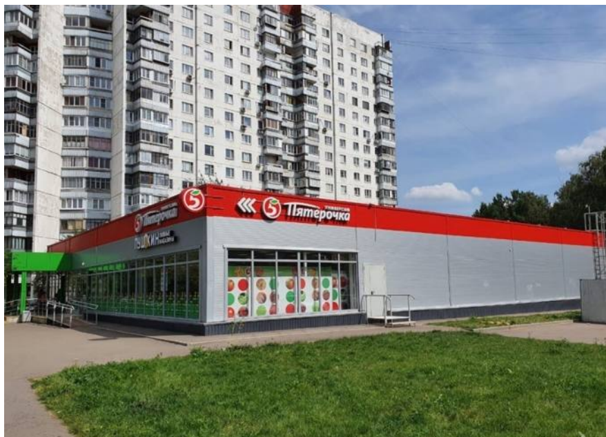
Фото 1. Внешний вид здания
