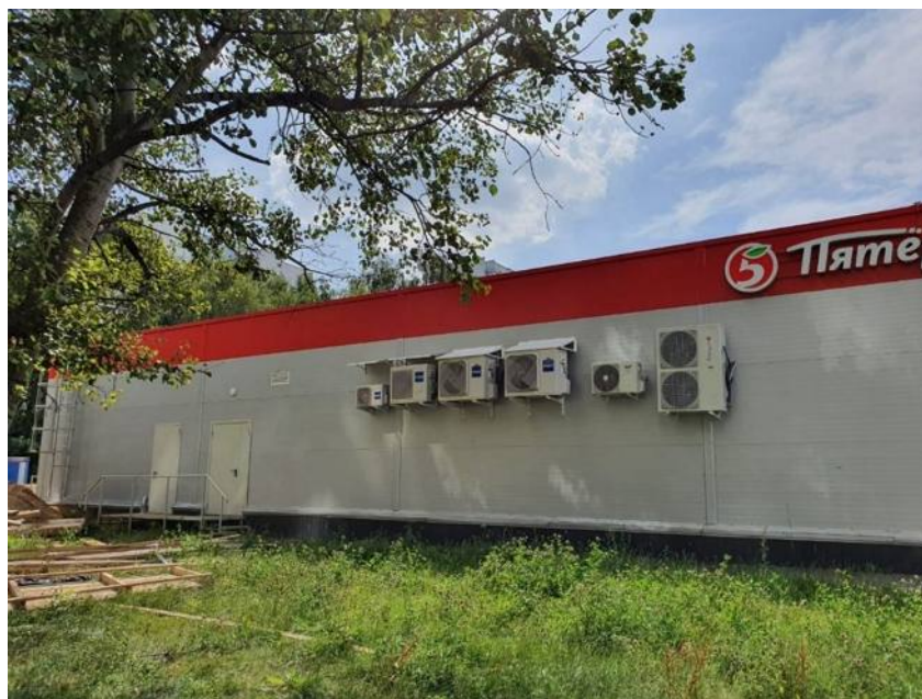
Фото 3. Внешний вид здания
