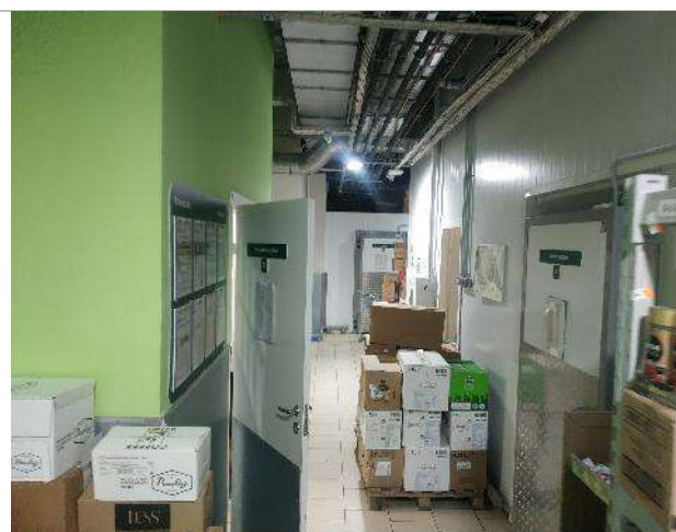
Фото 27. Фрагменты внутренних помещений
