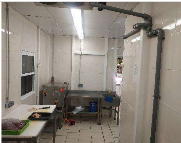
Фото 26. Фрагменты внутренних помещений
