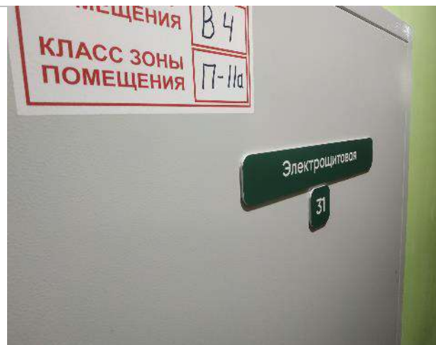
Фото 11. Фрагменты внутренних помещений
