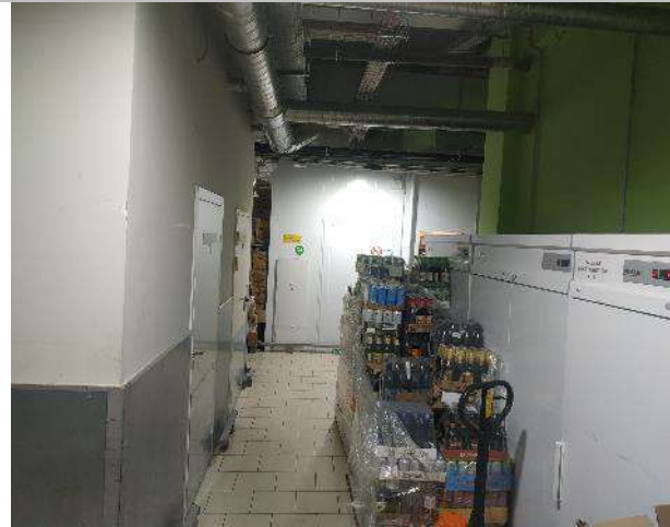
Фото 7. Фрагменты внутренних помещений
