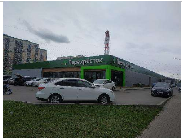
Фотография 3.4. Прилегающая территория, фасад здания
