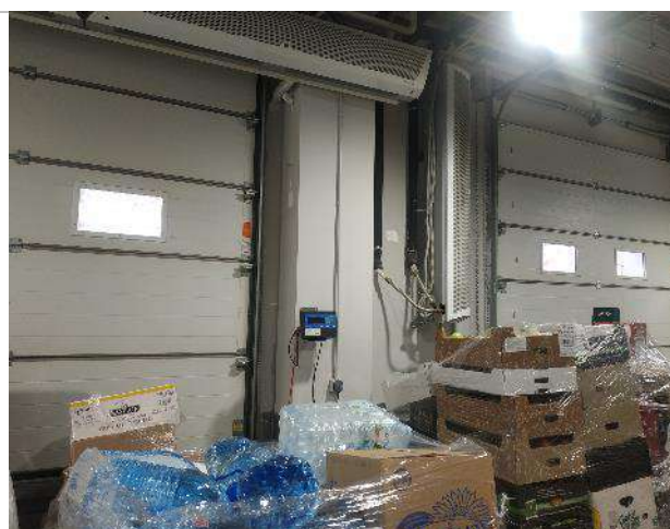
Фото 5. Фрагменты внутренних помещений
