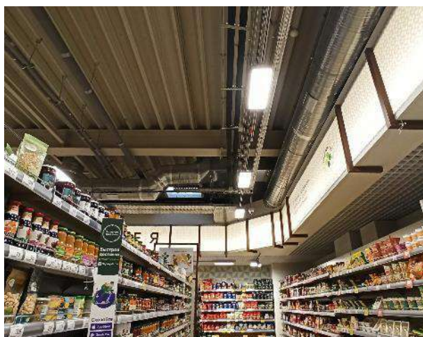
Фотография 35. Фрагменты внутренних помещений
