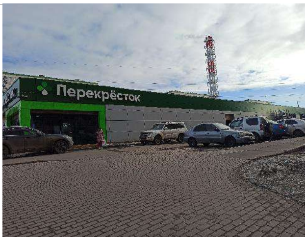
Фотография 3.4. Прилегающая территория, фасад здания
